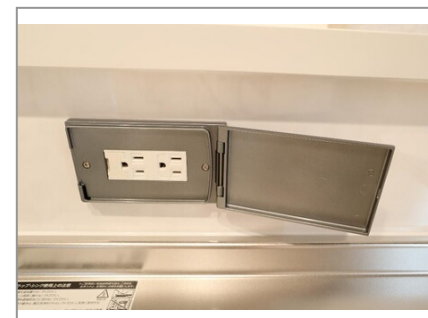
キッチンコンセント
