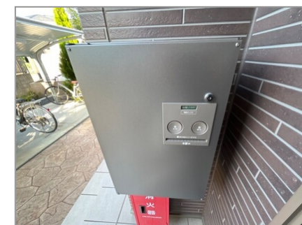
宅配ボックス
