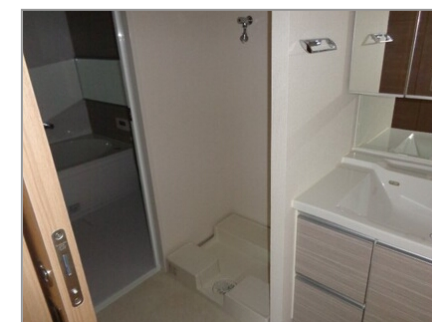
室内洗濯機置場
