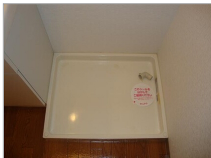
洗濯機置き場
