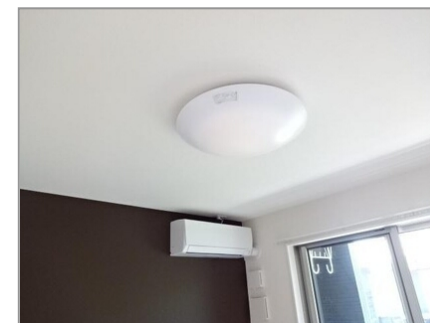
エアコン・照明
