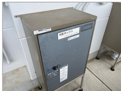
宅配ボックス
