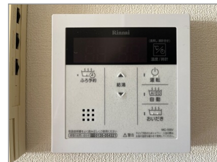
給湯器パネル
