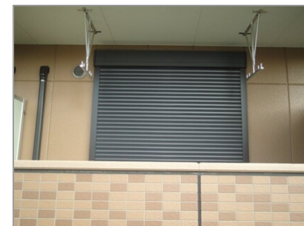
防犯シャッター
