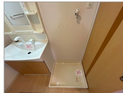
室内洗濯機置場
